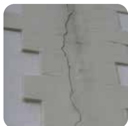
Bouwdynamische scheur
